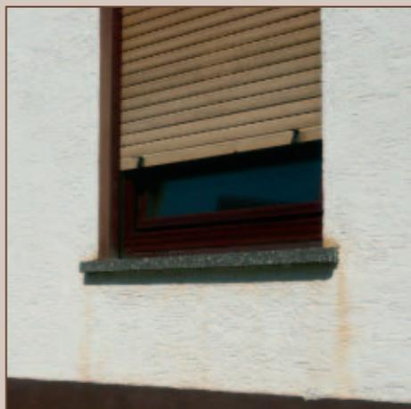
Schmutzabläufer aufgrund unterlassener Reinigung der Fensterbank.
